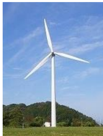
風力発電施設3号機
