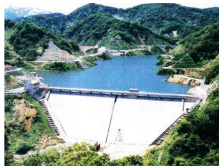
正善寺ダム（上正善寺地内）
